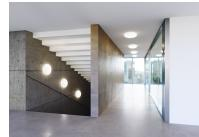
**Caractéristiques Ledvance Hublot LED 300 Blanc 24W 1920lm - 840 Blanc Froid | 300mm - IP65**
